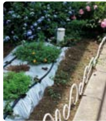
▲花壇の管理が大変との要望で設置された自動散水栓
